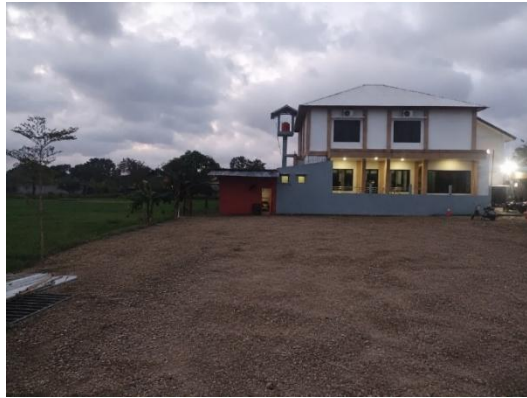
Gambar 2 Lokasi pembangunan sebelum pelaksanaan kegiatan
