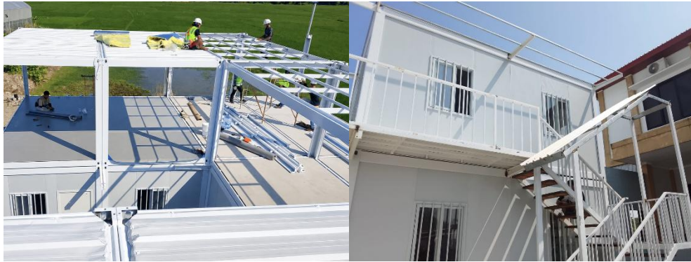
Gambar 6 Pemasangan rangka dan dan finishing
