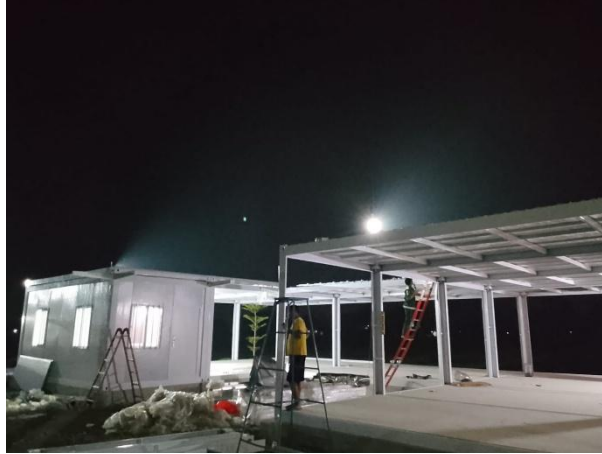
Gambar 5 Pemasangan panel lantai dan struktur atas
