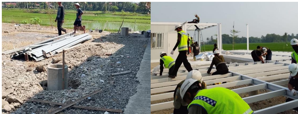
Gambar 4 Pekerjaan pondasi dan perakitan struktur
