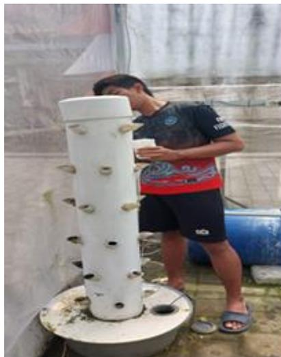
**Gambar 4 Pengecatan Hidroponik *Tower* dengan Cat Pelapis Anti Bocor**
