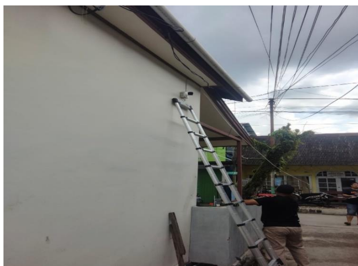
Gambar 2 Proses Pemasangan CCTV
