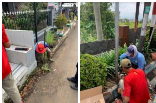
Gambar 6 Penggalian Lubang Pondasi dan Pemasangan Tiang Penyangga Cermin Convex
