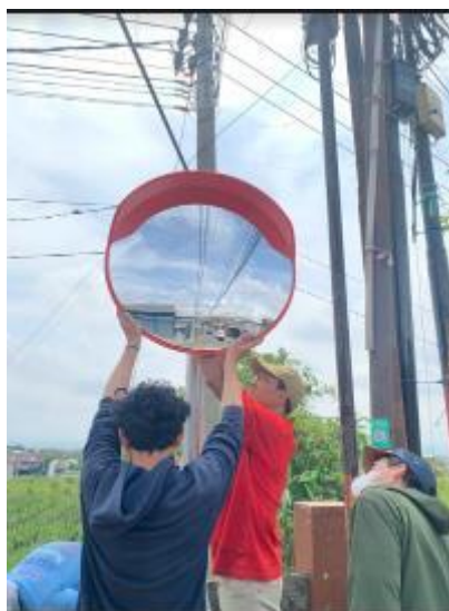
Gambar 8 Pengaturan Arah Pantulan dan Kemiringan Cermin Convex
