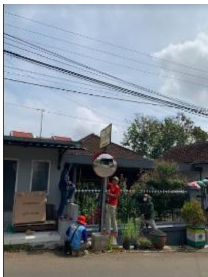
Gambar 7 Pemasangan Cermin Convex pada Tiang Penyangga
