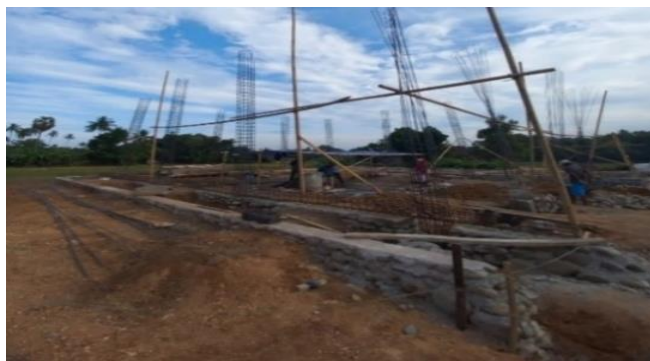
Gambar 6 Proses Pembangunan Pondasi Masjid Suraenny Ramlan
