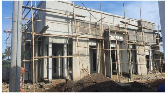
Gambar 10 Proses Pembangunan Pelesteran Dinding Masjid Suraenny Ramlan
