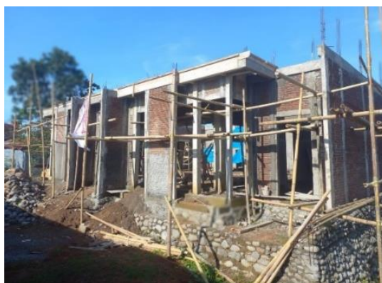
Gambar 9 Proses Pembangunan Ringbalk Beton Masjid Suraenny Ramlan
