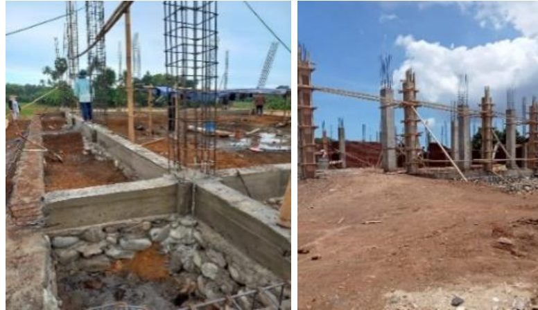
Gambar 7 Proses Pembangunan Kolom Masjid Suraenny Ramlan
