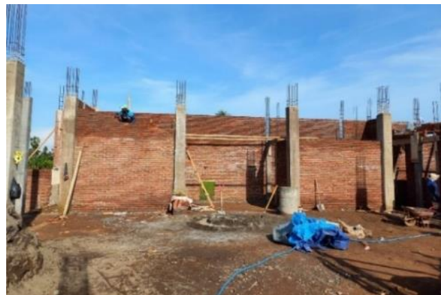
Gambar 8 Proses Pembangunan Dinding Pasangan Bata
