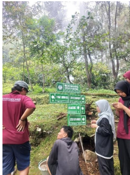
Gambar 5 Pemasangan Titik Pertama
