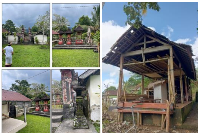
Gambar 1 Kondisi Aktual Bangunan-Bangunan Pada Kompleks Pura Dadia Teben Dayang
