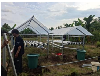
Gambar 3 Proses Pembangunan Dua Modul Hidroponik
