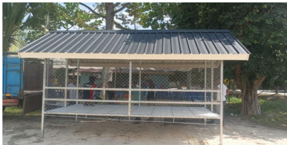
Gambar 3 Unit kandang kambing dengan konstruksi baja ringan
